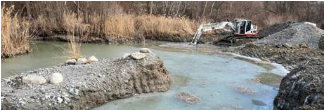
Baggerarbeiten für den neuen Teich
