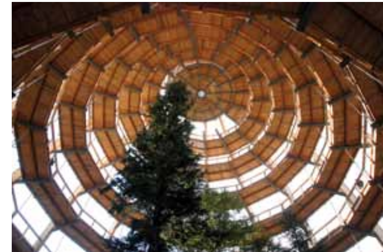
Abb. 29: Eine beeindruckende Konstruktion, der 44 m hohe Aussichtsturm mit dem spiralförmig nach oben führenden Aufgang.
